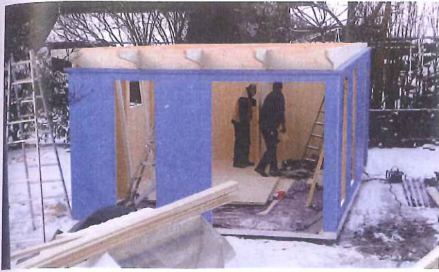
Das Gartenhaus wird aufgebaut.
