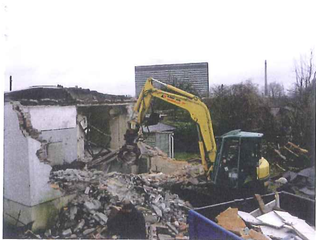
Abriss des alten Behelfsheims im Januar 2012.
