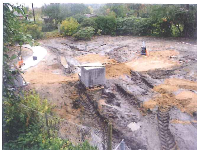
Regen, Lehm und Matsch: Die Gartenbaustelle im Oktober 2012.
